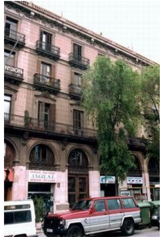
Font: Fitxa del Catàleg de Patrimoni Arquitectònic de l'Ajuntament de Barcelona.
