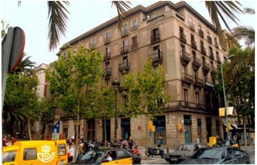
Font: Fitxa del Catàleg de Patrimoni Arquitectònic de l'Ajuntament de Barcelona.
