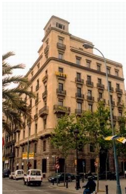
Font: Fitxa del Catàleg de Patrimoni Arquitectònic de l'Ajuntament de Barcelona.
