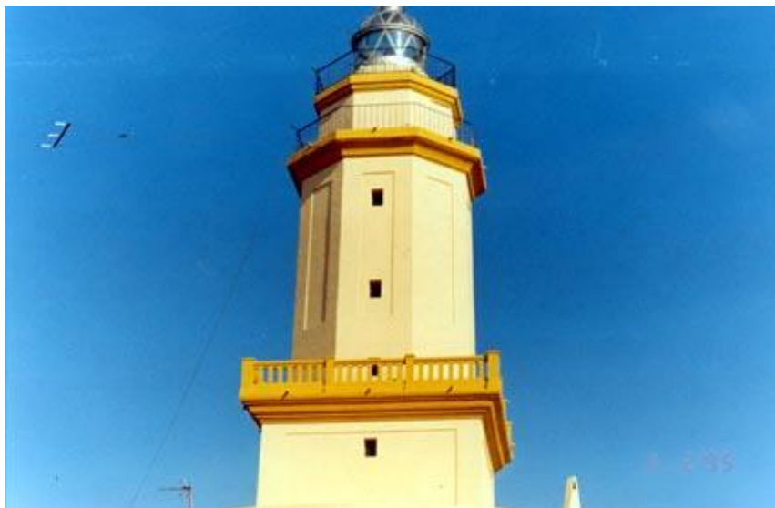
Font: Fitxa del Catàleg de Patrimoni Arquitectònic de l'Ajuntament de Barcelona
