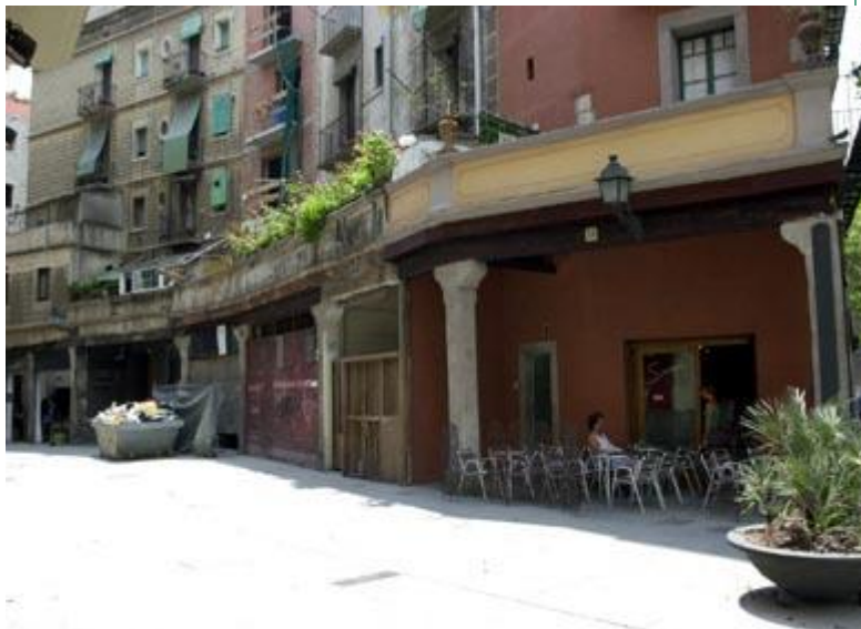
Font: Fitxa del Catàleg de Patrimoni Arquitectònic de l'Ajuntament de Barcelona.
